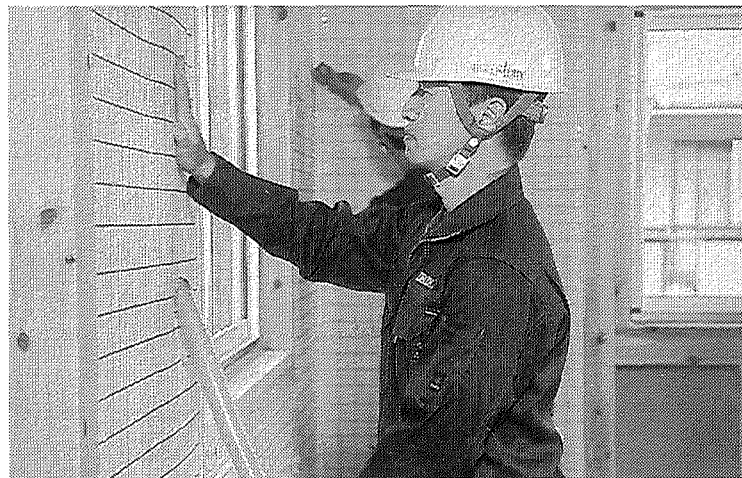
独自の乾式吹込み工法「デコスドライ工法」
